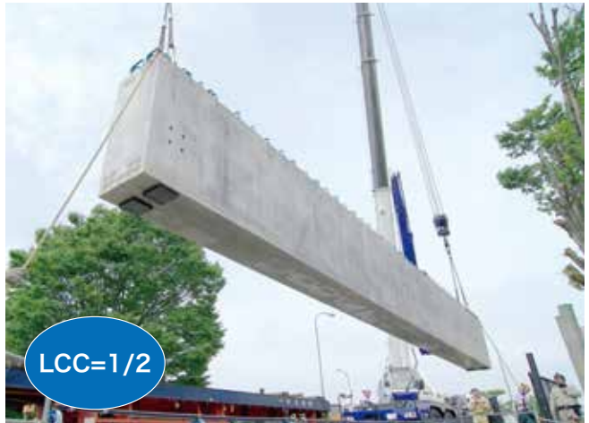
▲ 図14：低炭素コンクリート+ノンメタル例「ゼロセメントコンクリート+アラミド緊張材」(2019年)
