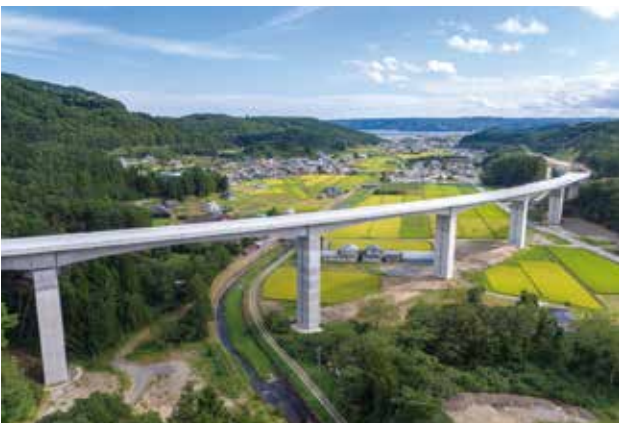
▲ 三陸沿岸道路 夏井高架橋
