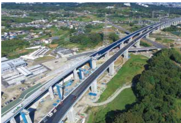
▲新東名高速道路 秋山高架橋
