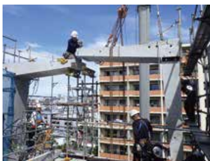
▲ ファサードとなるPCa部材の施工状況
