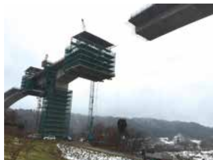
▲ 片持ち架設中の橋梁
