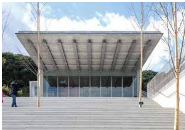
▲ 吊り構造屋根
