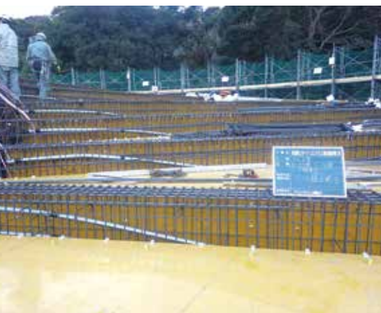
▲ 場所打ち PC 梁の施工
