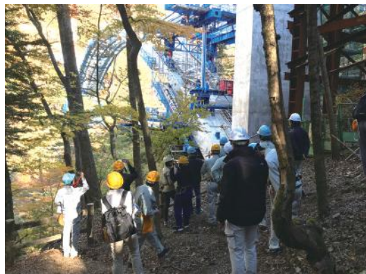
▲ 下塩原第一橋梁の現場見学の様子
