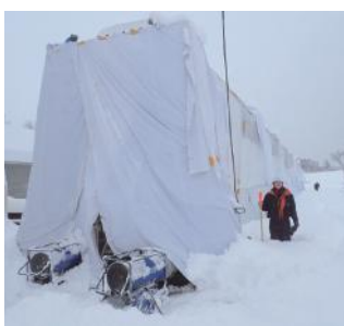
▲ ドカ雪に見舞われた現場(養生上屋と筆者)
