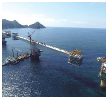
▲ 片持架設状況
