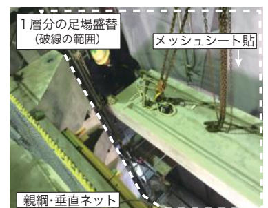
▲写真-6:ルーバー部材据付実施状況
