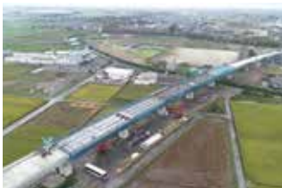
▲ 東海環状下宮第4高架橋全景
