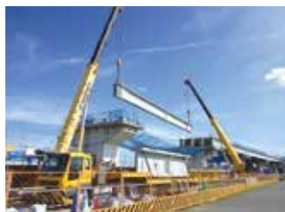
▲ 大型クレーンによる架設
