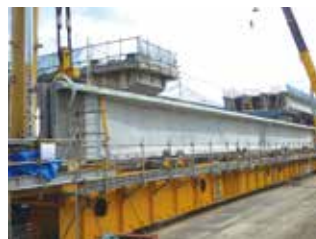
▲ 主桁組立完了
