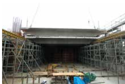
▲床版の架設状況
