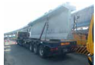
▲ セグメント桁搬入
