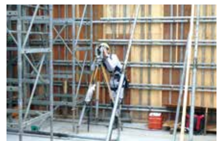
▲プレキャスト部材の設置位置を確認中
