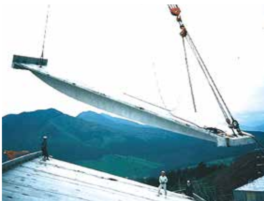
▲ PCaPC 屋根の架設状況
