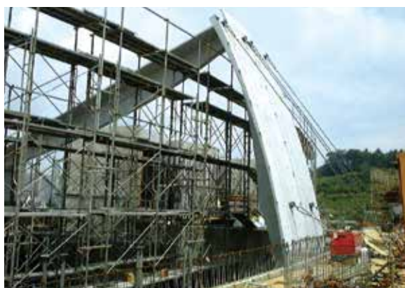
▲ PCaPC 壁・PCaPC 屋根の施工状況
