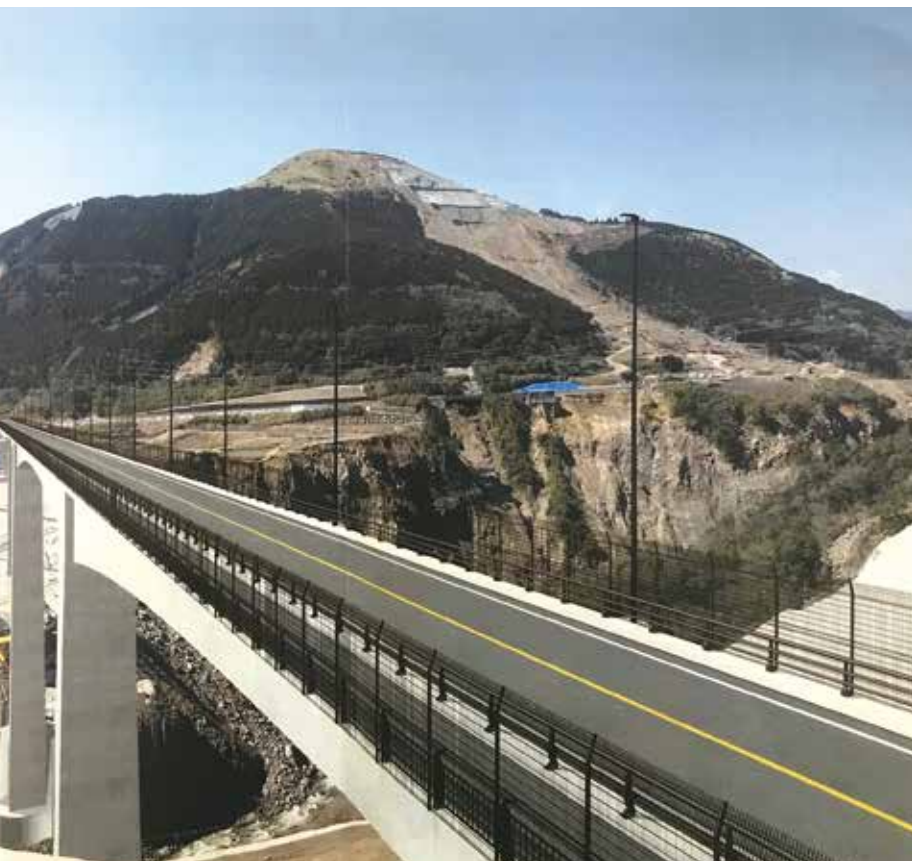
▲ 阿蘇大橋完成予想イメージ 熊本地震による斜面崩壊で落橋した阿蘇大橋の下流約600mの箇所に、新しい阿蘇大橋を建設中。PC3径間連続ラーメン箱桁橋、橋長345.0m。
