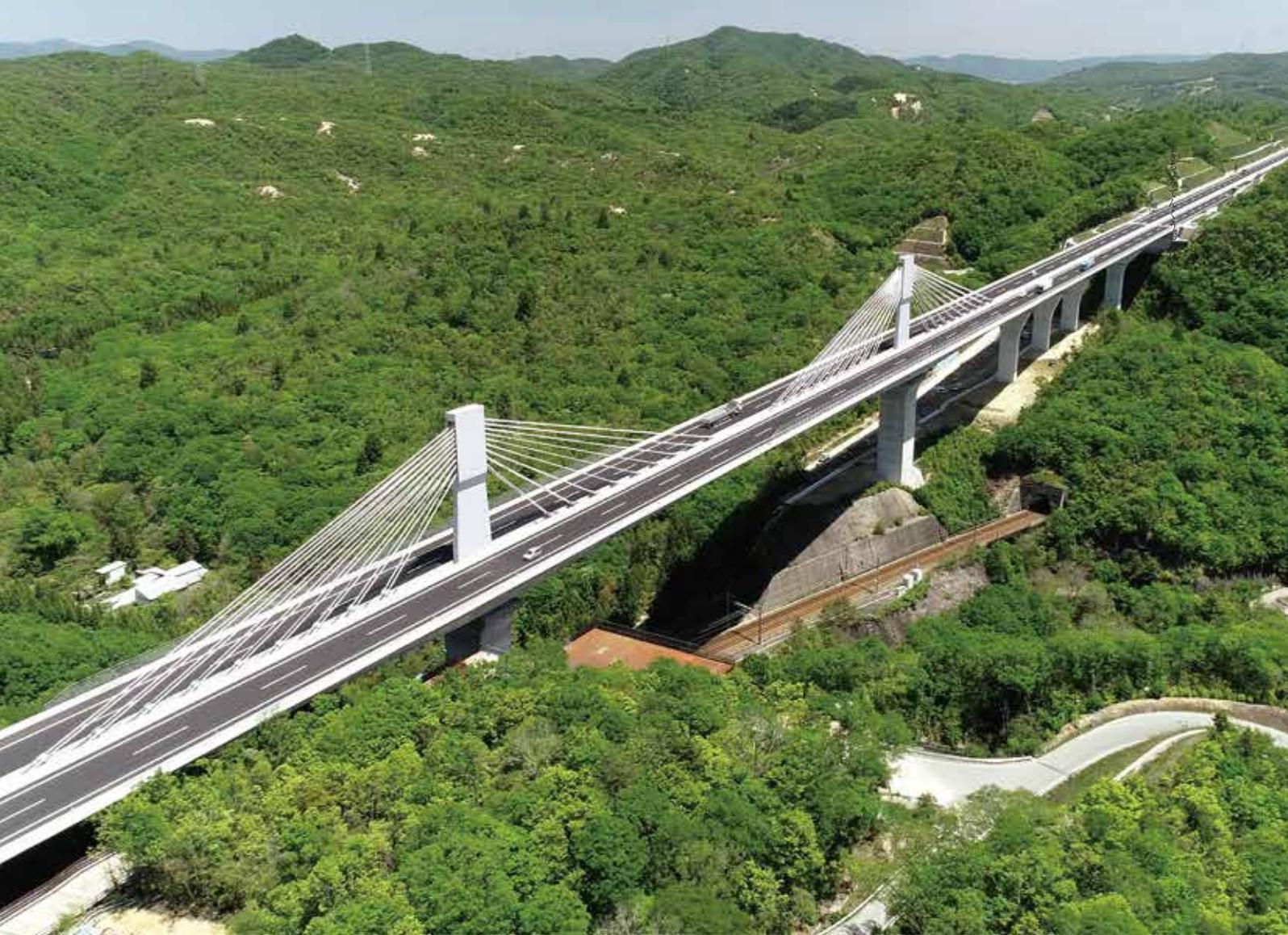
新名神高速道路（高槻JCT―神戸JCT）が、平成30年3月18日に開通しました。生野大橋は、開通した路線のPC橋の中でも最大規模の橋梁で、開通時のCM・ポスターにも使用されています。JR福知山線を高架する施工条件から、橋脚部から少しずつ主桁を構築する張出し工法で架設し、平成26年2月から平成30年3月までの約4年間をかけて完成しました。新名神高速道路の開通は地域の期待も大きく、施工期間をいかに短くするか、直下の鉄道輸送に對しいかに安全を確保するかが当時の課題でした。これらの課題に對し実施した取り組みについてご紹介します。
