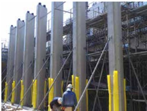
▲ 架設完了したプレキャストRC細柱
