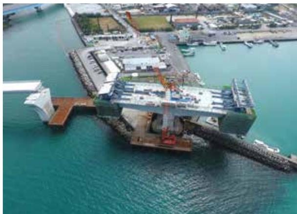
▲ 特殊移動作業車による張出施工状況
