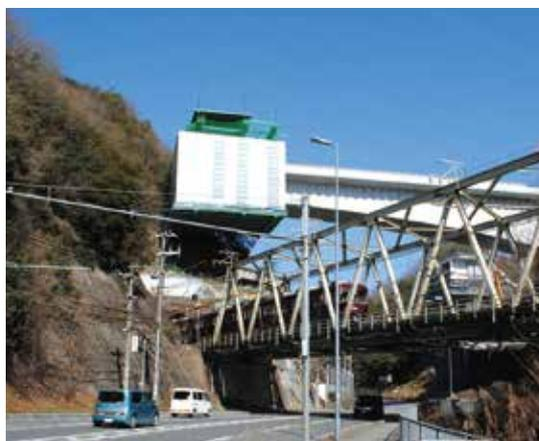
▲ 鉄道上空で施工中の移動作業車
