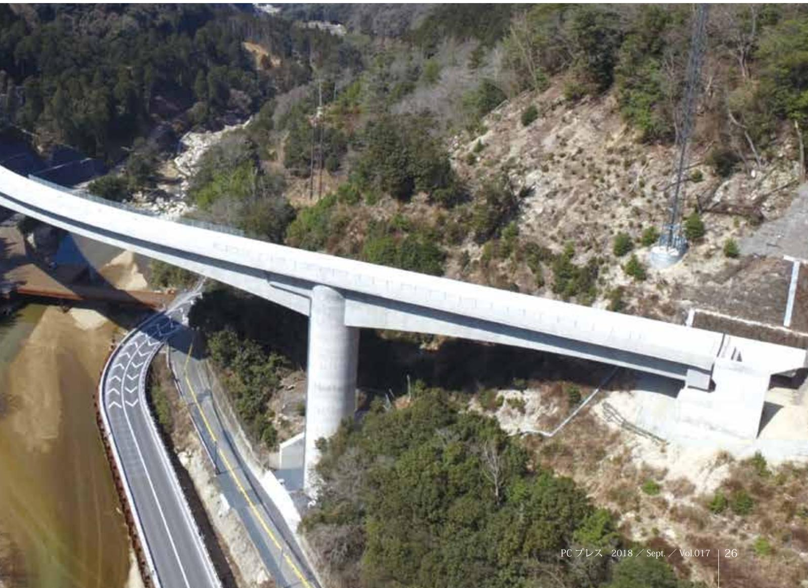
上部工は平面線形R $\parallel$ 200m、中央径間127mを有した不等径間の曲線橋であり非対称となる片持架設は、さまざまなPC技術を駆使して閉合を行いました。
