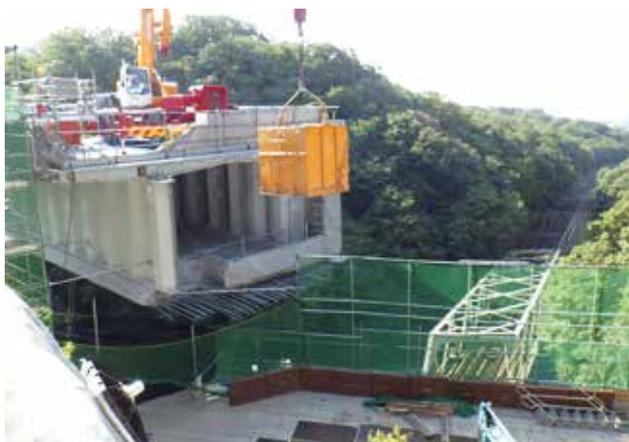
▲ 上部工張出先端からの橋台施工
