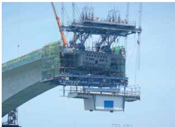
▲ 接合桁の吊上架設状況
