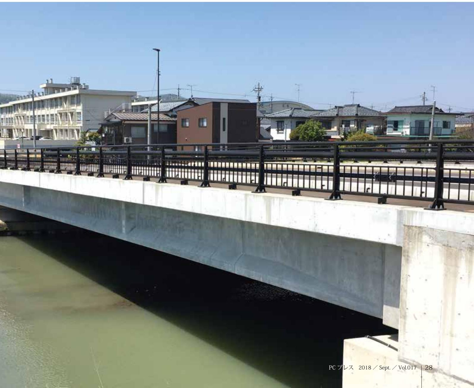
た。FAコンクリートの採用にあたり、耐久性に関する試験(浸せき試験、凍結融解試験、表層透気試験)を実施し、十分な抵抗性を有していることを確認しました。
