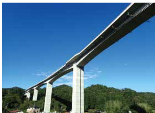
▲ 相馬福島道路 月館高架橋
