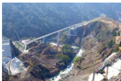
▲ 一足先に開通した阿蘇長陽大橋
