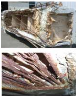
▲写真-4 開通後38年で架替えPC中空床版橋(湖山橋)
