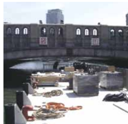
▲ 写真1 浮体の曳航状況
