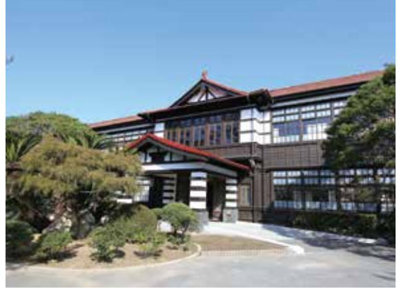
▲萩・明倫学舎 最近まで授業が行われていた明倫小学校の木造校舎を補強・改造して、「萩・明倫学舎」として2017年3月にオープン。内部に歴史資料など様々な展示物があり、新たな観光施設になっている。
