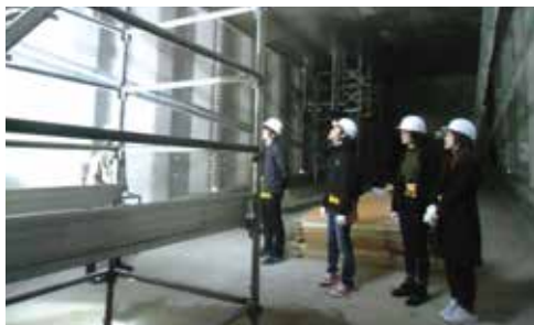
波形鋼板ウェブの見学(安威川橋)
