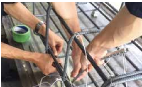
熱電対の設置作業中
