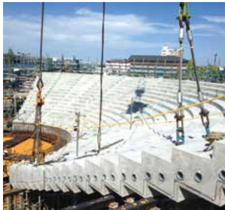
▲ 写真5 ふわふわコフン施工状況
