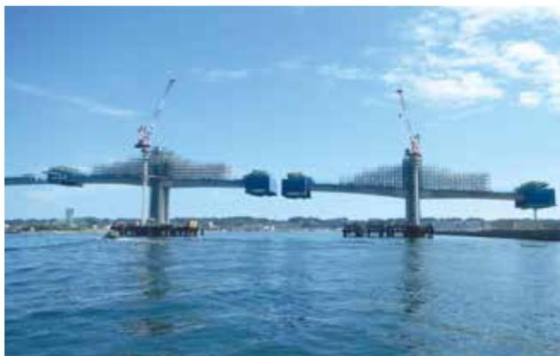
▲ 移動作業車を用いた張出し架設
