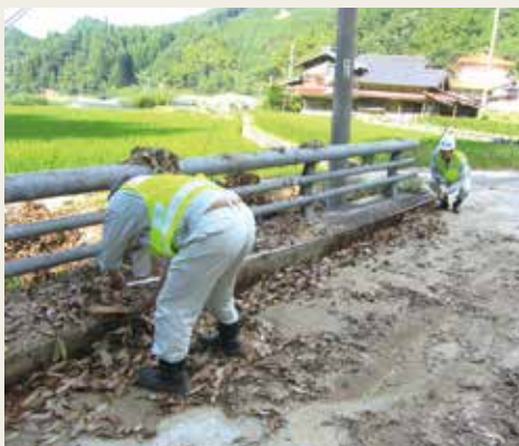
▲ 橋梁を点検する調査班
