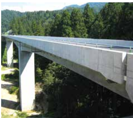
▲ 中部縦貫自動車道 永平寺大野道路 轟4号橋
