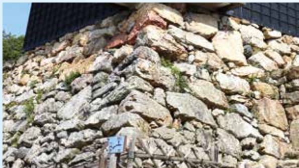
▲ 野面積みの石垣 浜松城の石垣は、自然石を積み上げる野面積みという工法で造られた。石の大きさや形はバラバラで不安定に見えるが、戦国時代に手がけたものが、そのまま残っている。
