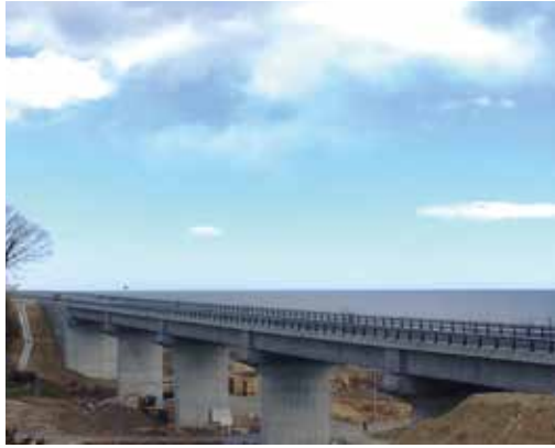
▲久之浜バイパス 古内橋
