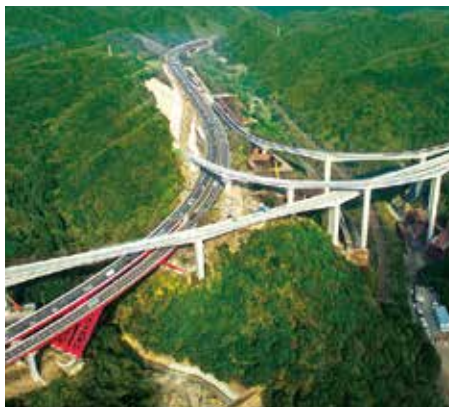
▲ 京奈和道路和歌山JCT全景
