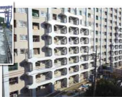
▲ 住宅の耐震補強工事
