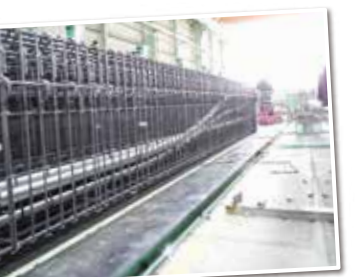
▲ PCa 部材製作状況
