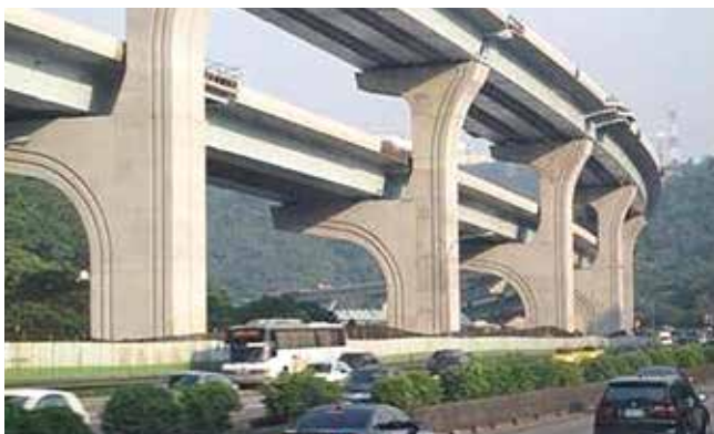
▲台湾における高速道路車線拡張プロジェクト (道路の重層化構造：F型橋脚)
