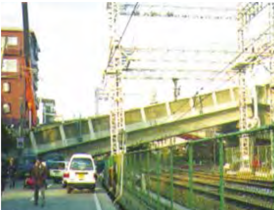
▲再利用したPC桁（被災直後）
