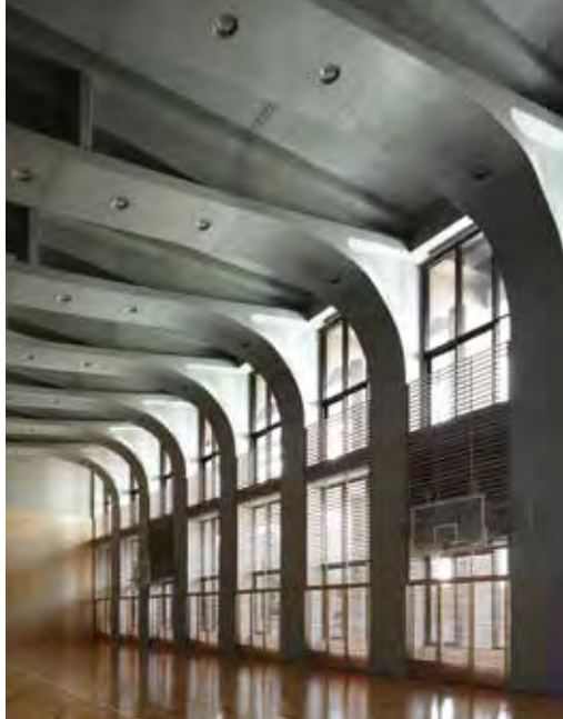
▲ 写真3 体育館内観
