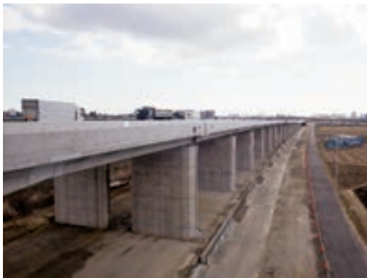
仙塩道路/多賀城高架橋
