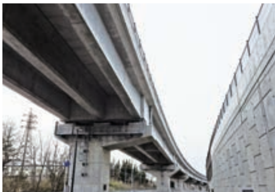
栗東水口道路／葉山高架橋
