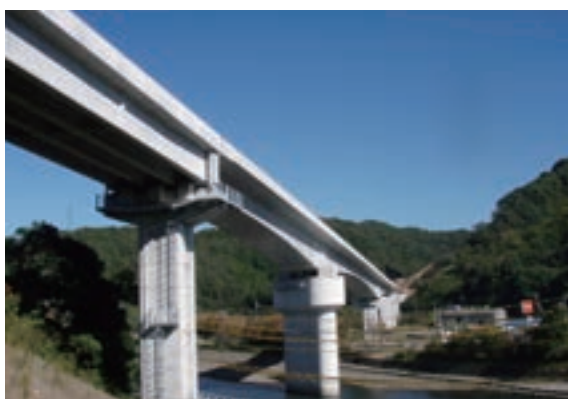
芦北出水道路／湯浦川橋
