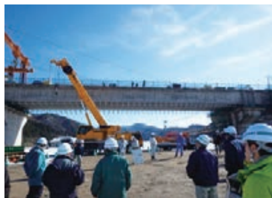
現場見学会／浜坂道路久斗大橋
