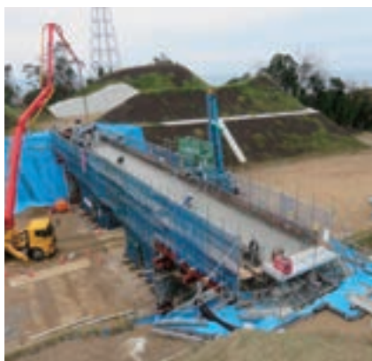
コンクリート打設完了直前の全景
