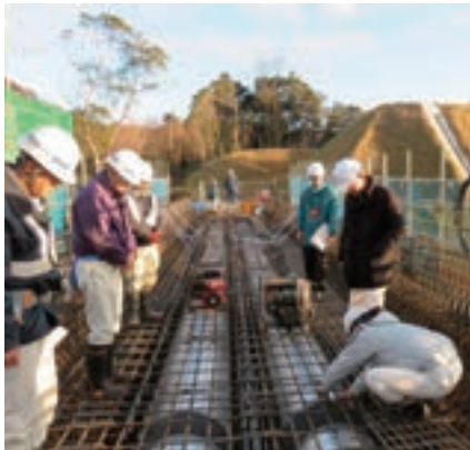
コンクリート打設前鉄筋確認状況
