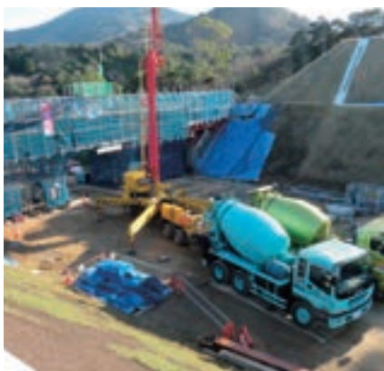
コンクリート打設状況全景
