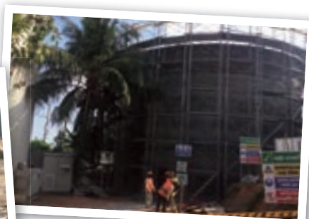
PCタンク施工
