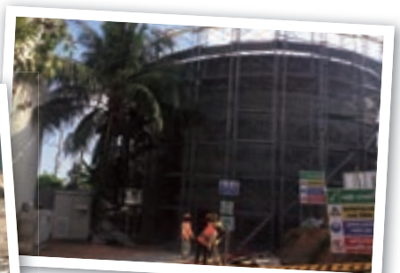
PCタンク施工
