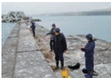
写真-2 堤防の劣化度調査
