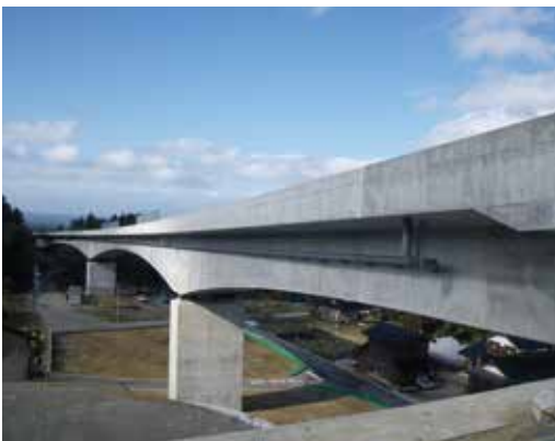
北陸地区 城山高架橋
