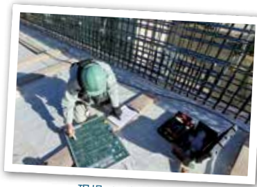
現場での仕事状況
