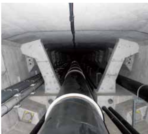
桁断面農水道
