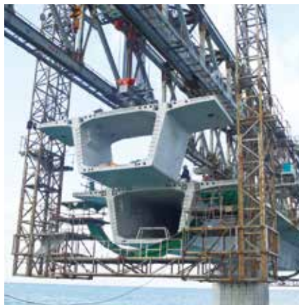
セグメント架設
