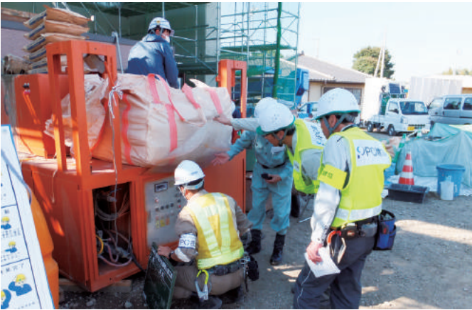
グラウト診断 圏央道大生郷橋上部工事
