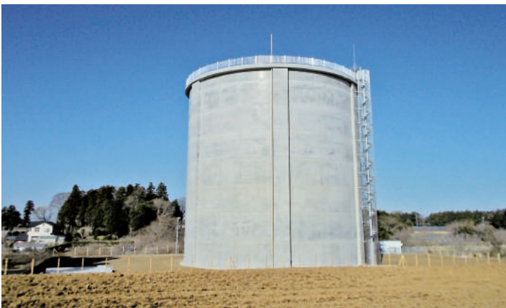
かんがい用水を供給するためのPC調整水槽
