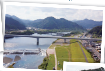
番匠川橋全景
