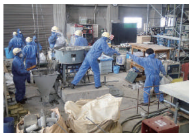
写真-5 打設の様子
