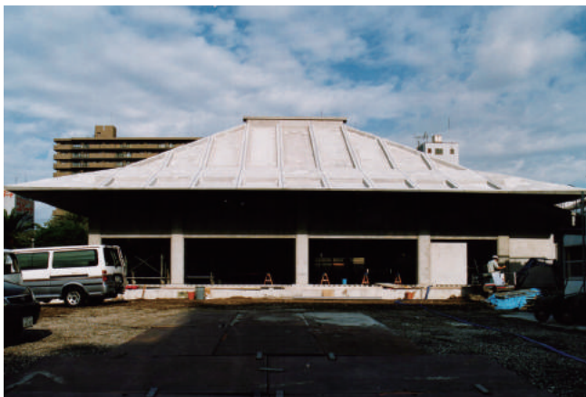
構造躯体完成写真
