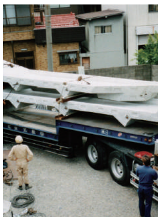
PC屋根版搬入状況
