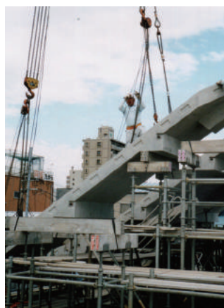
PC屋根版建方状況
