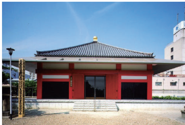
竣工後の本堂正面
