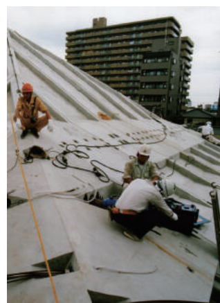
PC屋根版緊張状況
