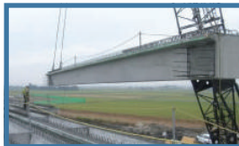
PCコンボ橋 (I桁) 主桁をプレキャストセグメント工法で製作し、床版にはプレキャストPC板を使用したPC合成床版を採用。⇒作業性、安全性の向上、品質向上。
