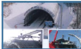
防災構造物 (スノーシェルター、ロック・スノーシート*) プレキャスト部材(工場製作)を接合させて一体化した防災構造物。⇒作業性、品質向上。
