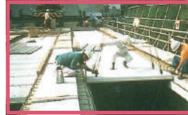
型枠兼用PC板 工場製作の薄いPC板を型枠代わりに用いて施工する。合成構造の利点を活かしながら支保工、型枠の組みばらしが不要となる。⇒作業性、安全性の向上。
