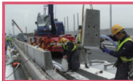
プレキャスト壁高欄 (橋面工) 地覆高欄をブロックに分割して工場で作成し、現場で組み立て、接合する。⇒作業性、安全性の向上。品質向上。
