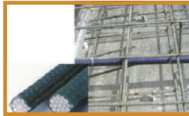
プレグラウトPC鋼材 あらかじめ後硬化型の樹脂が塗布され、その外側をシースに包まれたPC鋼材。現場でのグラウト作業が不要。⇒現場作業の省力化、工期短縮。
