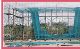
鉄筋のプレファブ化 現場型枠内で配筋をするのではなく、別ヤード・工場等で鉄筋だけを組み立て(プレファブ)現場に持ち込む。⇒作業性、安全性の向上。機械化の可能性が広がる。
