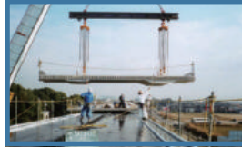
プレキャストPC床版 橋軸方向に分割したプレキャスト部材(工場製作)を接合させて一体化したPC床版。⇒作業性、安全性の向上。品質向上。
