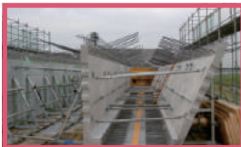
プレテンションウェブ 箱桁等のウェブ部材を現場で施工するのではなく、工場製作プレテン部材を用いて施工する。軽量化、施工の省力化が図れる。⇒作業性、安全性の向上。品質向上。
