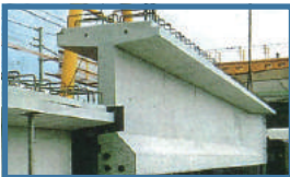
PCコンボ橋 (I桁) 主桁をプレキャストセグメント工法で製作し、床版にはプレキャストPC板を使用したPC合成床版を採用。⇒作業性、安全性の向上、品質向上。
