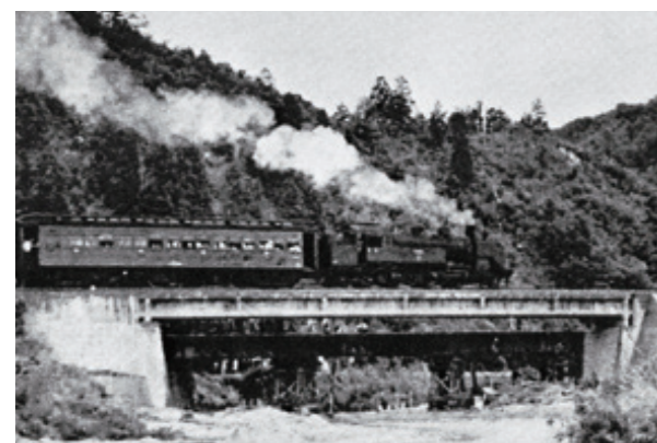
写真-5 第一大戸川橋梁
