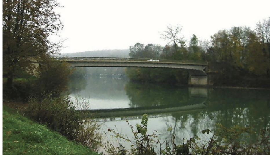
写真-1 ルザンシー橋梁
