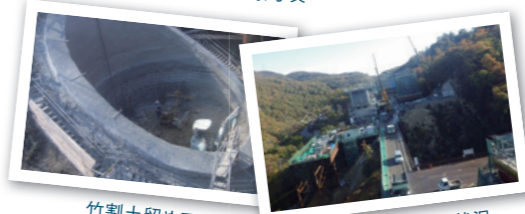
竹割土留め工
