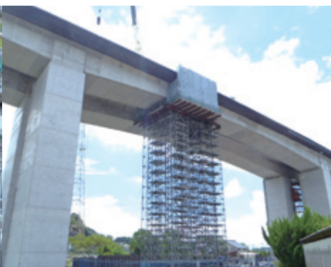
切断部を支える支柱
