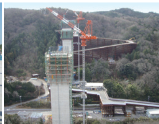
クライミングフォームによる橋脚施工と仮栈橋
