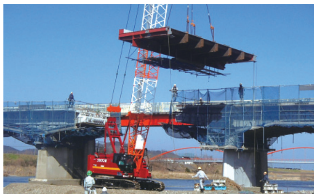
ゲルバー桁部の架設
