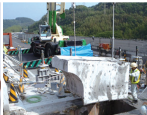
切断したブロックの撤去
