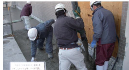
スラブコンクリート打設状況
