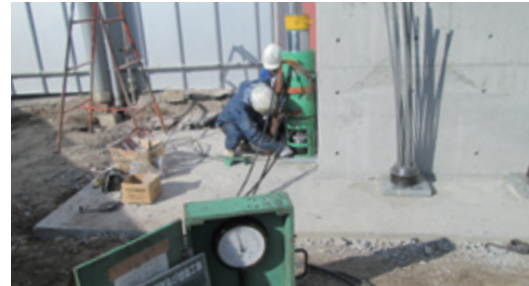
鉛直地盤アンカーPS導入状況
