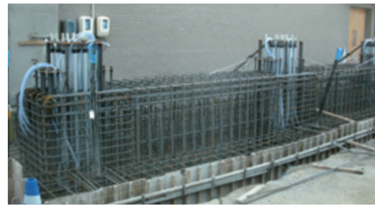
基礎梁配筋状況
