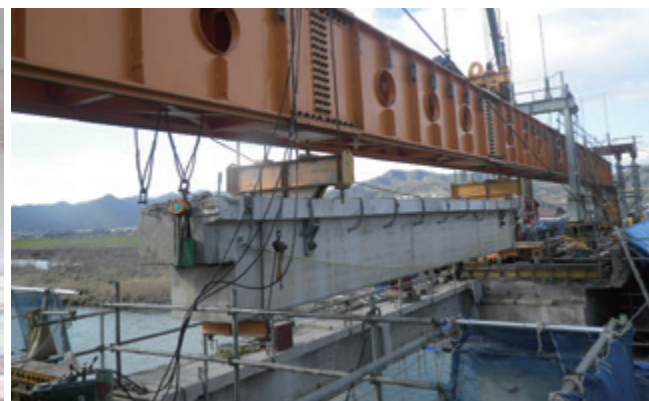
ゲルバー桁部の撤去
