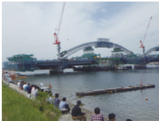
アーチ大ブロック架設
