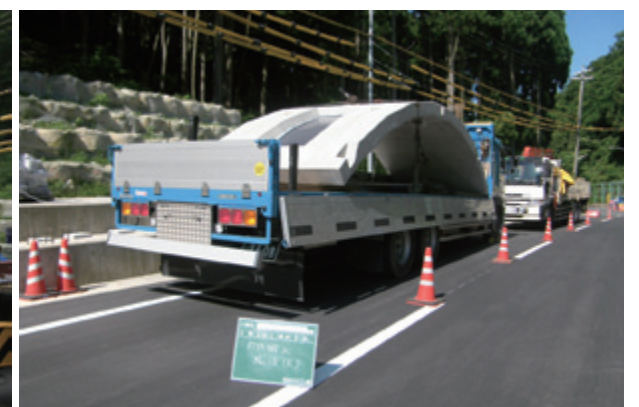
部材運搬状況
