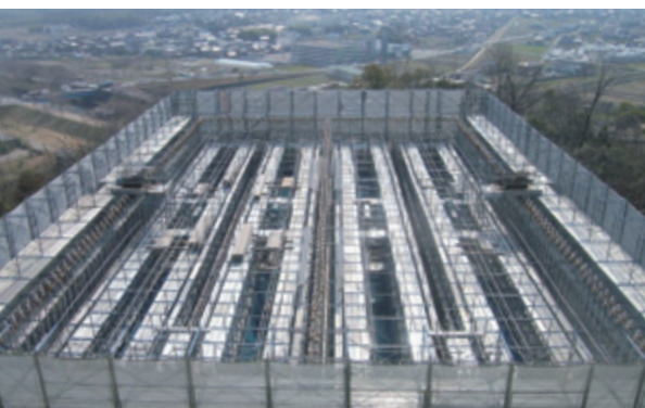
壁部施工状況
