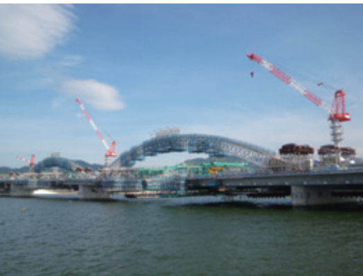
ヤジロベエ施工
