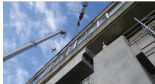
PC梁建て方状況
