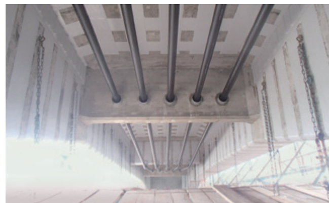
外ケーブルの設置
