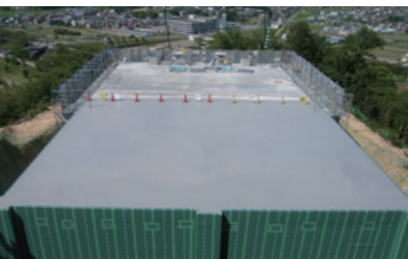
埋戻し前・防根シート貼付状況
