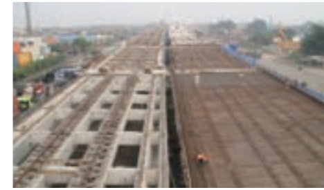
高架橋スラブの施工
