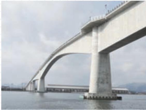
CMの舞台となった江島大橋は、鳥取県境港市と島根県松江市の間に位置する1級河川斐伊川(中海)を渡り、両市を結ぶ全長1.4キロにも達する橋梁です。この橋は、取付高架橋と主橋梁部で構成され、主橋梁部は5径間連続の有ヒンジPCラーメン橋です。主橋梁部の中央支間の長さは250mで、これはPCラーメン橋として、国内はおろか東洋で第1位、世界でも第3位の長さになります。
