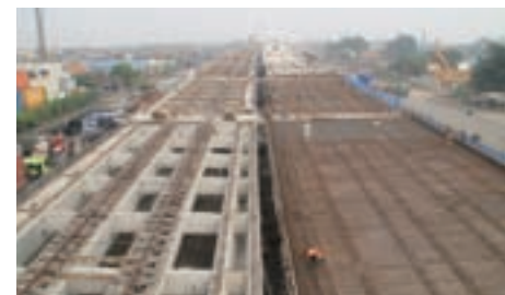
高架橋スラブの施工
