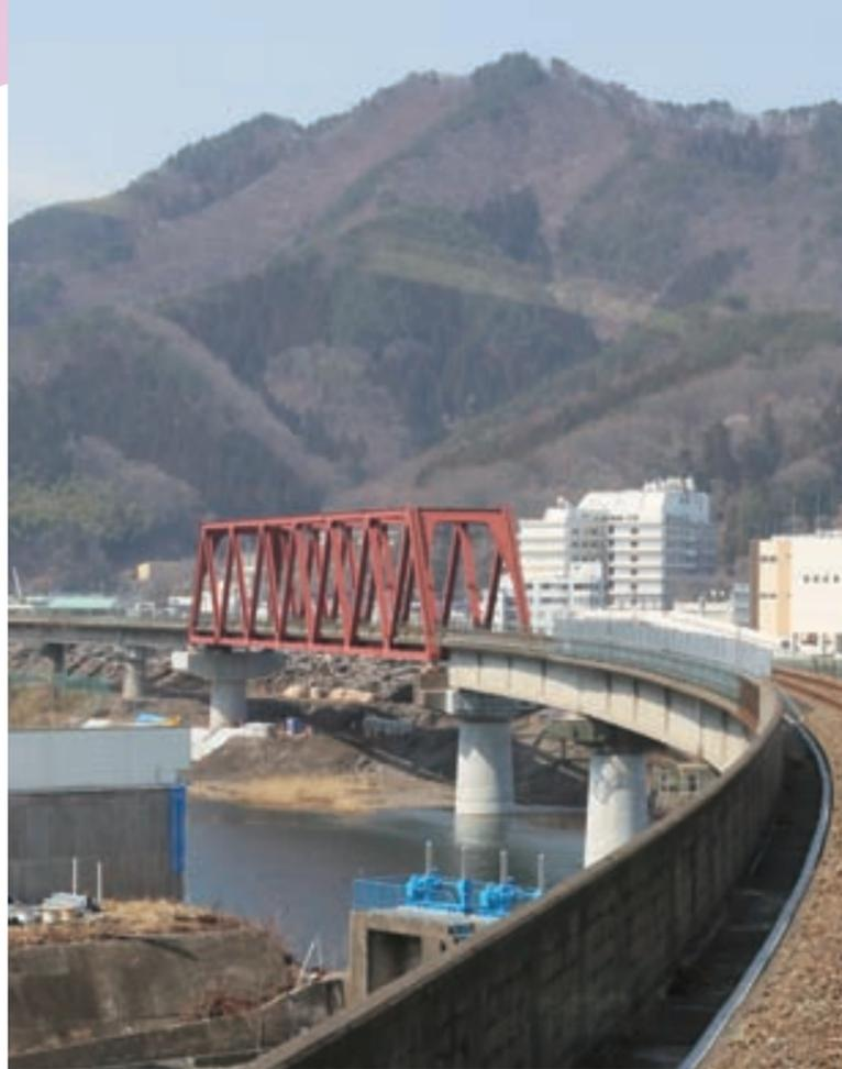
大渡川橋梁 大がかりな修復工事が必要だったが、PC桁は補修して使用している
