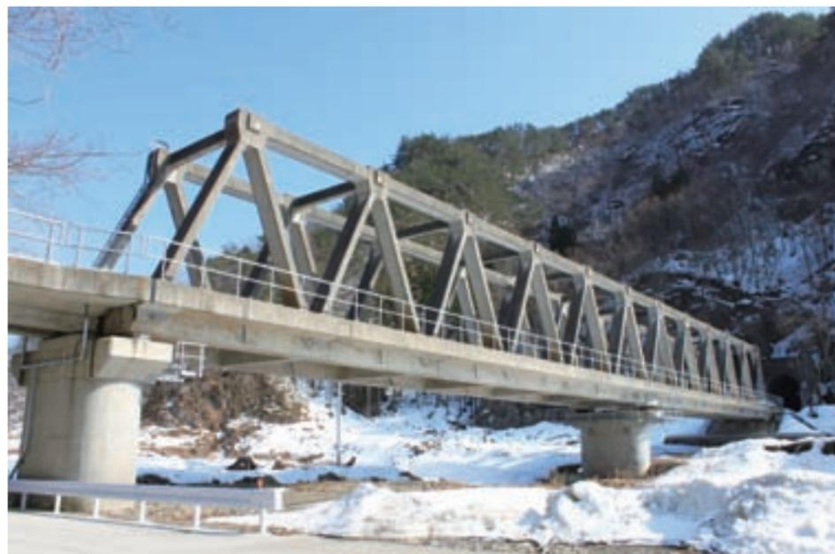
横木沢橋梁 日本で最初のPCトラス連続橋で、張出架設で施工した 上部工が津波の被害を受けた
