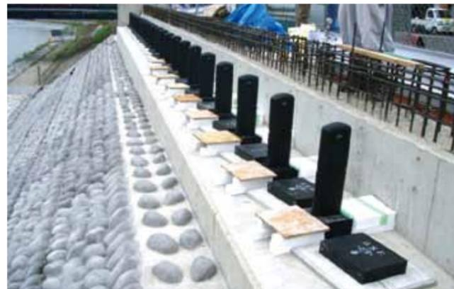
パッド型ゴム支承とアンカーバーの組合せによる支承部構造の写真
