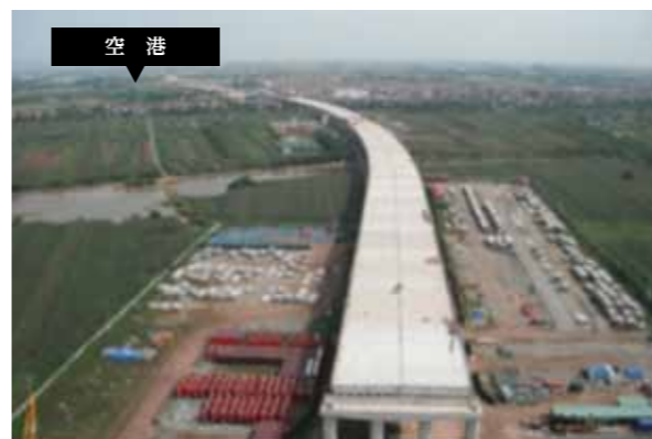
空港 アプローチ橋(Super-T桁橋+PC箱桁 / P.16より終点側)
