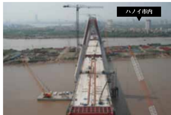
ハノイ市内 メイン橋梁(P.16より起点側)
