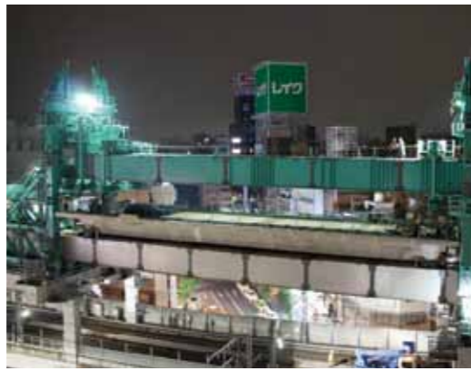
写真-3 深夜の桁架設準備作業
