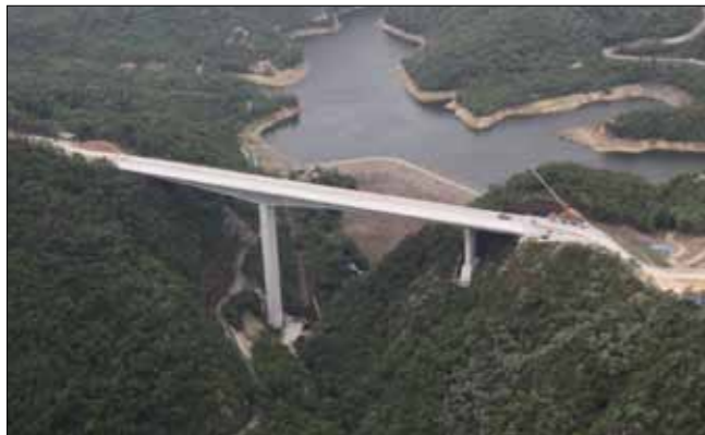
写真-1 川下川橋(連続ラーメン箱桁橋)
