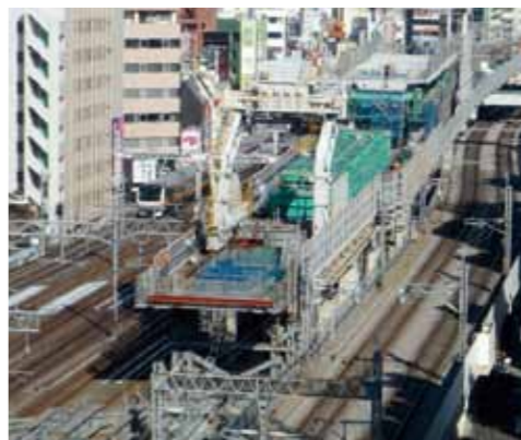
写真-1 PC桁組立状況
