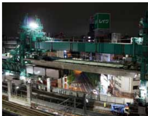
写真-4 走行ガーダーの先送り
