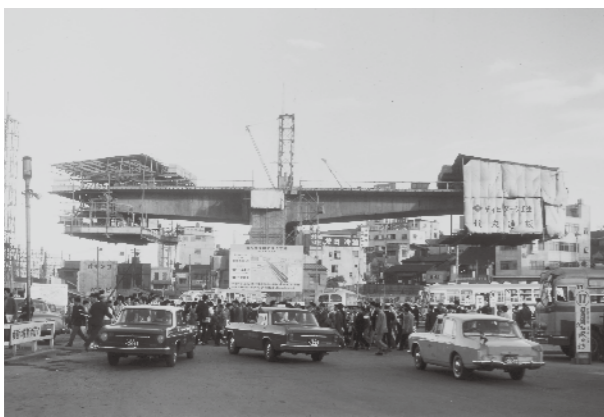
当時の渋谷駅西口からの架設の状況「ヤジロベエ工法」
