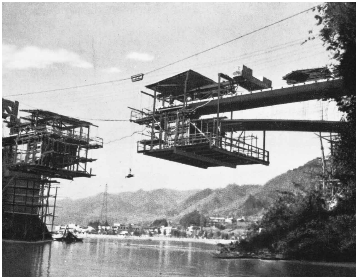
架設中の嵐山橋
